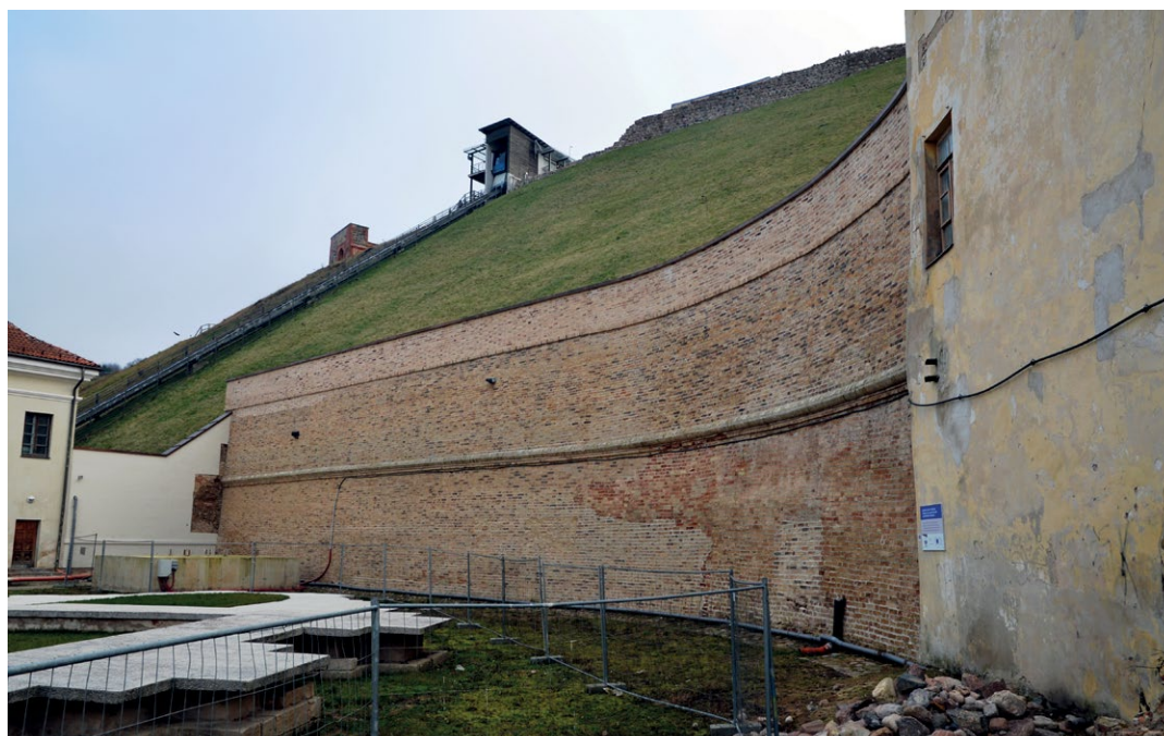
8. Mur oporowy z fortecznym kordonowym wałkiem, wcięty w naturalny stok Góry Giedymina (Zamkowej), wzniesiony w trakcie budowy kościoła pw. św. Anny i św. Barbary, czyli po 1553 r. Z lewej strony fragm. murów świątyni przykryty betonową płytą, za nim fragm. Domu Horodniczego, przystawionego do wcześniejszego odcinka muru oporowego z lat 1544–1546. Fot. K. Guttmejer, 2020 r.
