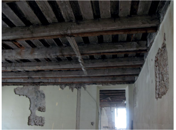
18. Strop z wtórnie użytych belek na piętrze.
