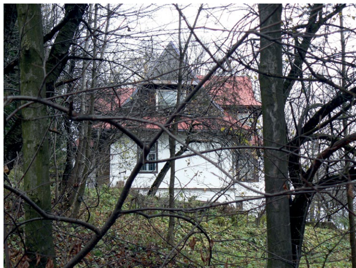
5. Pensjonat Modrzejów (obecnie nie istnieje), ul. Wierchowa 1 w Zakopanem, ok. 1882-84 r., wg proj. Adolf Opida, po pożarze w 1898 r. odbudowana wg projektu nieznanego autorstwa; 1929 r. – przebudowana wg proj. Adama Chełm-Pirgo; 1930 r. – przebudowa wg proj. Franciszka Kotońskiego. Fot. A. Nowakowska-Wolak
