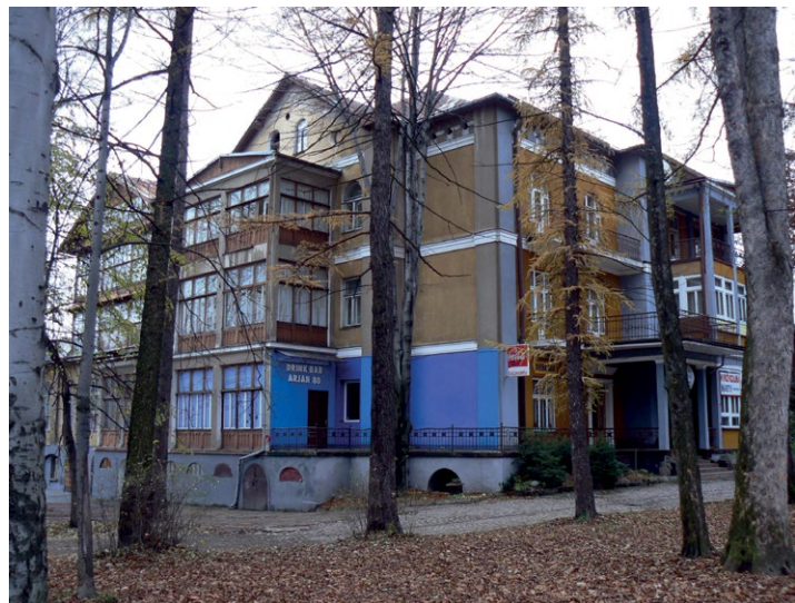
7. Sanatorium Warszawianka (obecnie nie istnieje), widok od strony północno-zachodniej. Fot. A. Nowakowska-Wolak
