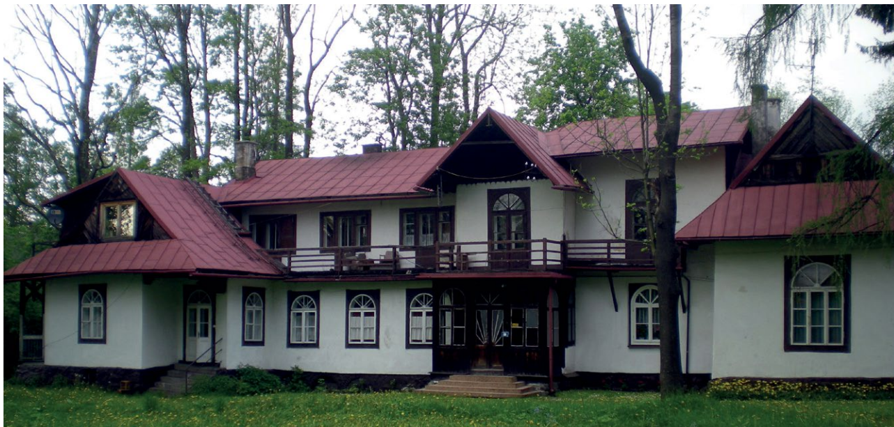
14. Pensjonat Chata (obecnie spalony pustostan), ul. Witkiewicza 19b w Zakopanem, pocz. XX w., widok fasady od strony ogrodu. Fot. A. Nowakowska-Wolak
