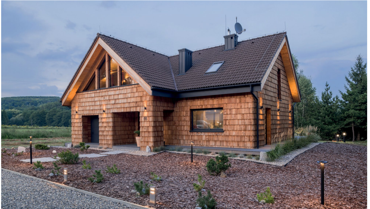
5. Dom Emil 2.0 , Biuro architektoniczne Karpziel i Steindel oraz Studio projektowe VOSTOK Design. Fot. P. Ulatowski, www.essystem.pl/realizacje/186;emil-house-20 [dostęp 20 X 2020]
