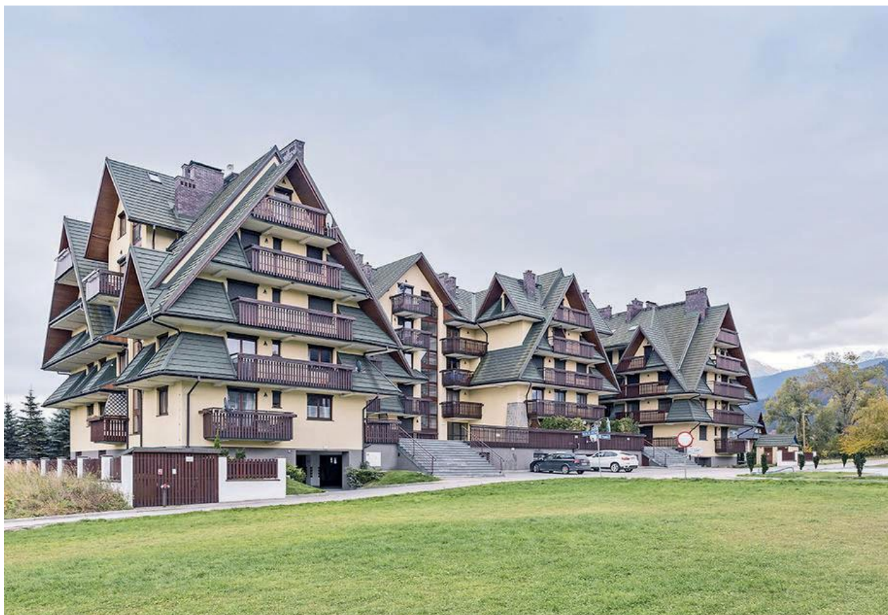
1. Hotel , arch. Maria Stępniewska-Szulc. Fot. wg: Marcin Czechowicz, w: architektura.muratorplus. pl/krytyka/nowy-styl-zakopianski-fotoreportaz-marcina- czechowicza_8159.html [dostęp 20 X 2020]
