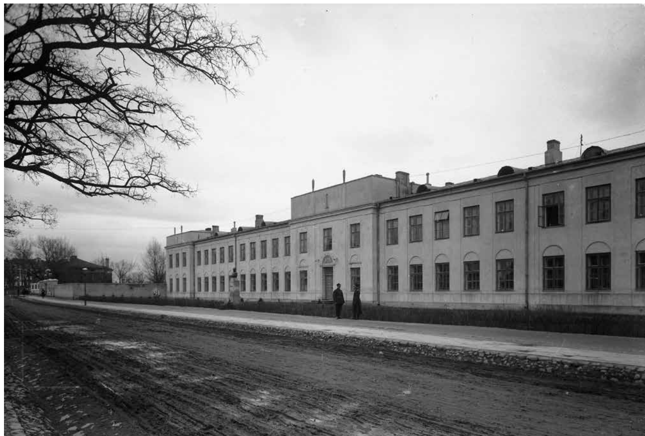
3. Przebudowany według projektu architekta Tołęczki budynek nr 50 w koszarach huzarskich. Narodowe Archiwum Cyfrowe, sygn. 107-956-1
