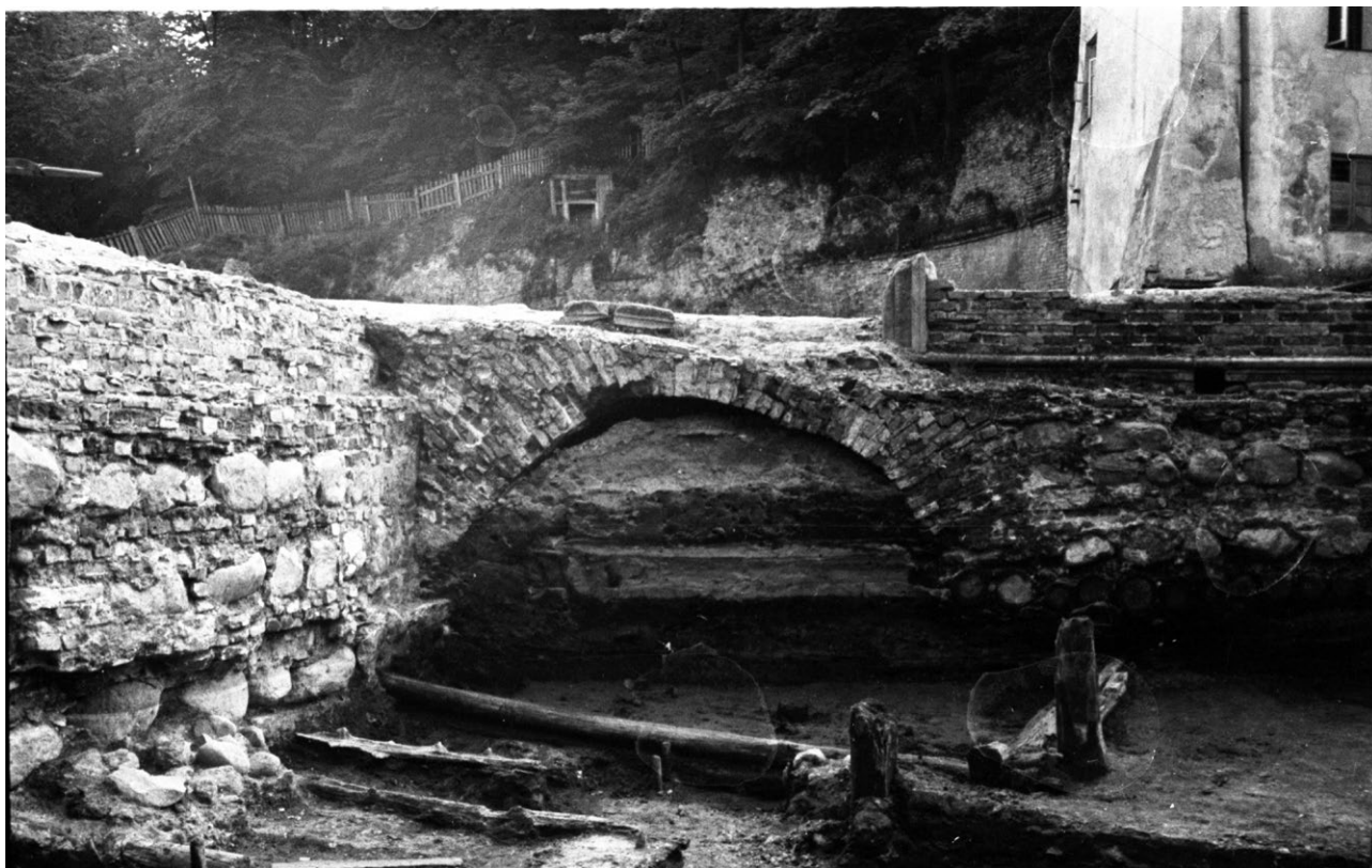
23. Odkopany fundament galerii prowadzącej do kościoła pw. św. Anny i św. Barbary, 1961 r. LIIR f. 1-92. Fot. LIIR
