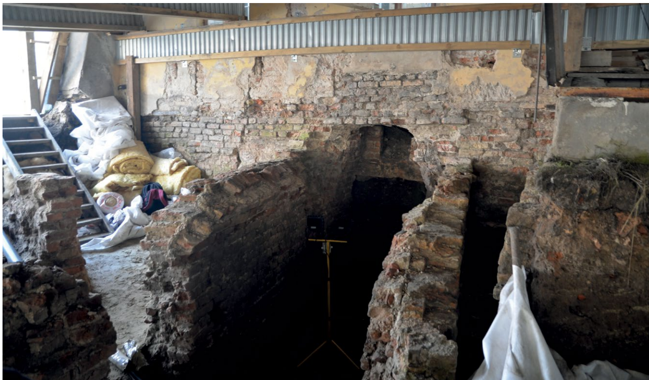
22. Odkopana szyja do zawalonej gruzem piwnicy P-1. Fot. A.S. Czyż, 2020 r.
