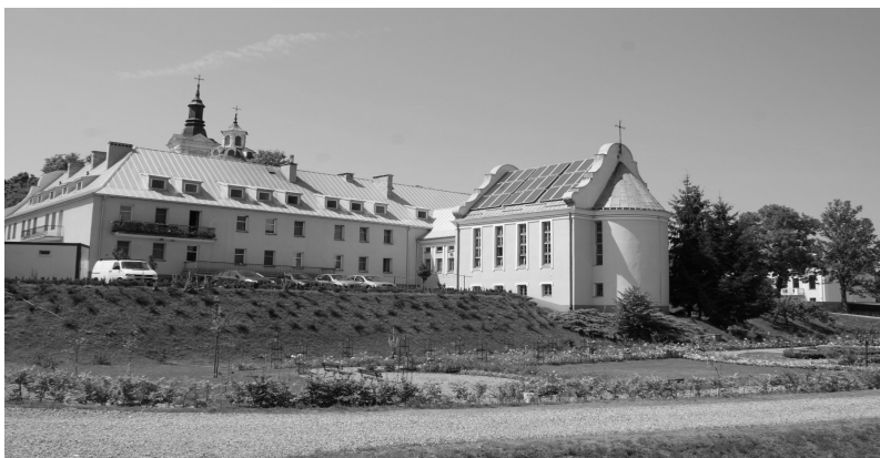
Fot. 2. Kolektory słoneczne na zadaszeniu budynku Klasztoru Misjonarzy Oblatów Maryi Niepokalanej w Kodniu (fot. autor)
